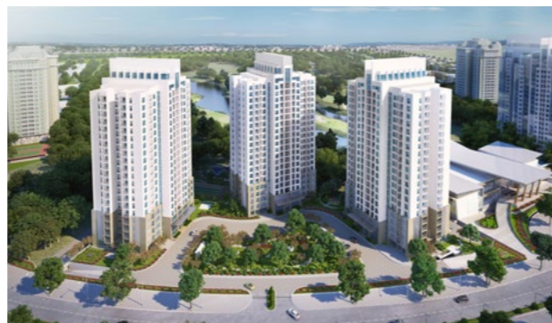
HỆ THỐNG VDP VÀ VIDEO WALL CIPUTRA
